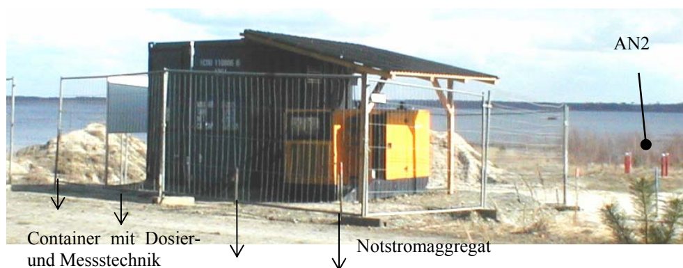
Abb. 3-11: Anlagen zur Reagenzienzugabe und Infiltration
