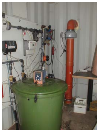
Abb. 3-10: Grundwasserumwälzung und Substratdosierung, links Ansicht der Anlagen im Container, rechts Schema
